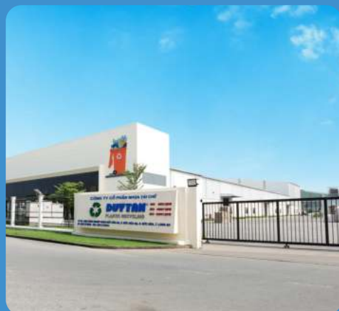
Công ty CP Nhựa tái chế Duy Tân (Long An) - Dự án cung cấp, thi công Hệ thống An ninh giám sát
