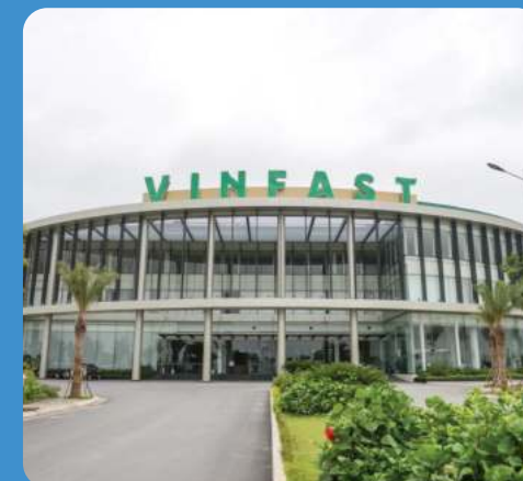
Nhà máy Vinfast Hải Phòng (TP. Hải Phòng) - Dự án cung cấp Thiết bị an ninh giám sát
