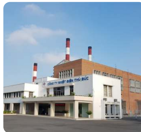
Nhà máy Nhiệt điện Thủ Đức (TP.HCM) - Dự án cung cấp Thiết bị an ninh giám sát
