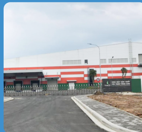
Nhà máy Pin ô tô Vinfast Vũng Áng (Hà Tĩnh) - Dự án cung cấp Thiết bị an ninh giám sát
