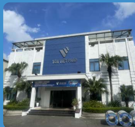
Công ty CP Tôn thép Việt Pháp (Bình Dương) - Dự án thi công lắp đặt Hệ thống an ninh giám sát
