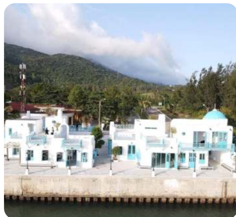
Marina Đà Nẵng (TP. Đà Nẵng) Dự án cung cấp, thi công Thiết bị an ninh giám sát + Mạng + Báo cháy
